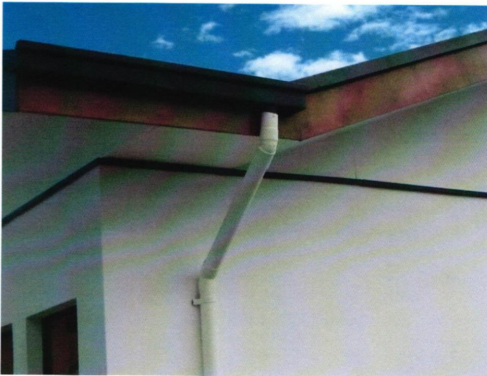
Fotografía N° 4: Otra vista de la bajada de aguas lluvias en PVC.
