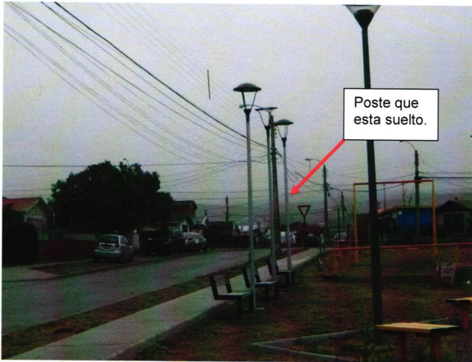
Fotografía N° 8: Vista general del poste con anclaje suelto.
