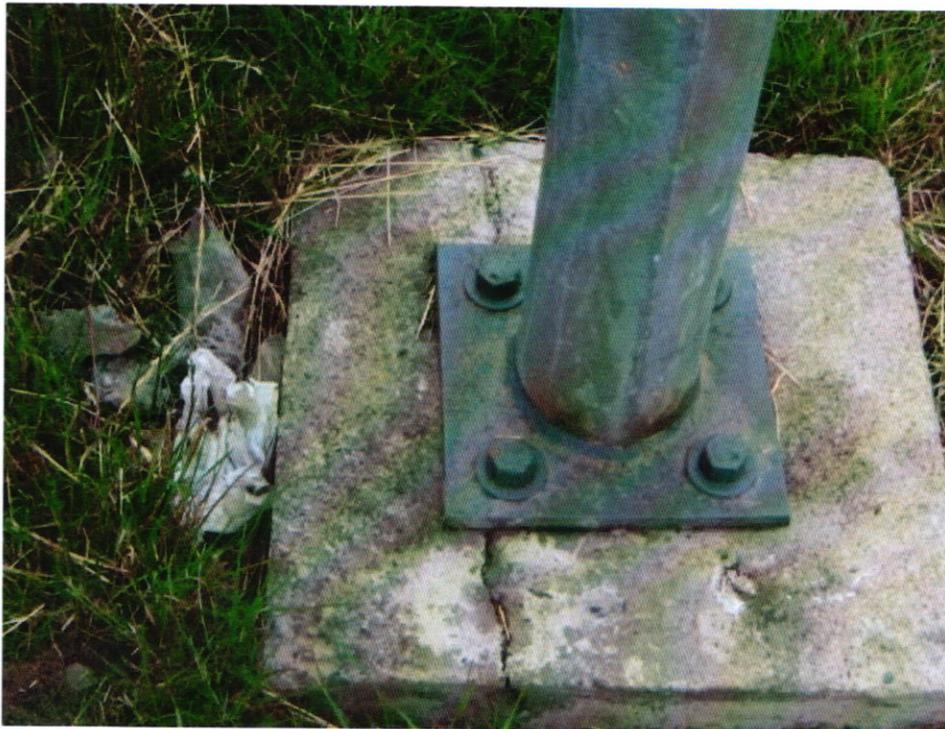
Fotografía N° 9: Dado de hormigón agrietado.
