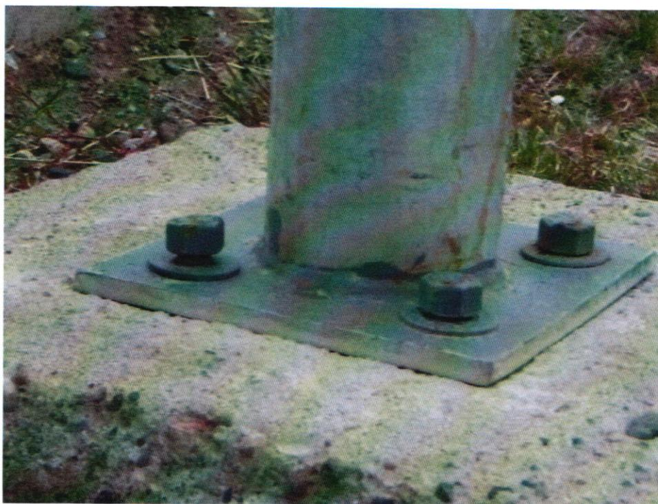
Fotografía N° 7: Pernos sueltos del poste de alumbrado.
