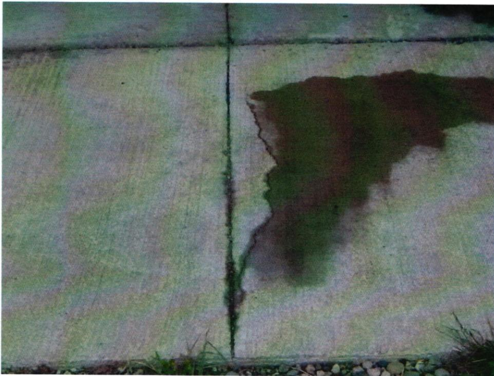
Fotografía N° 13: Fisura transversal en acera.
