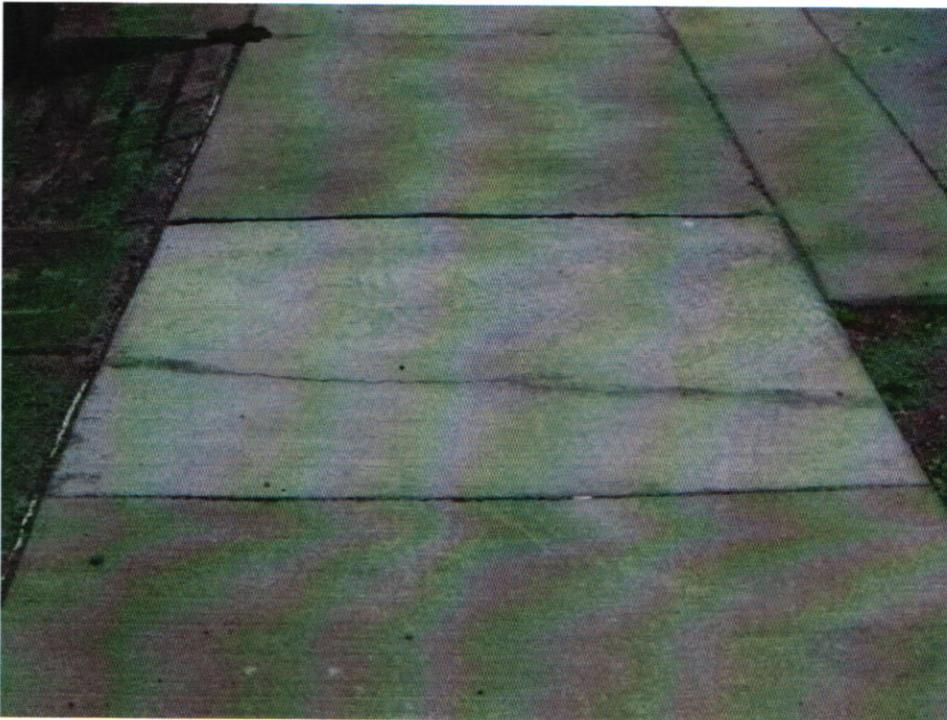
Fotografía N° 15: Fisura transversal en acera.
